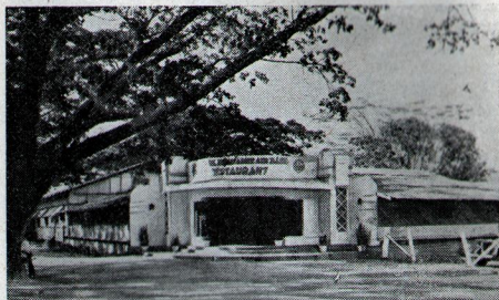
Het restaurant van Post Exchange.
